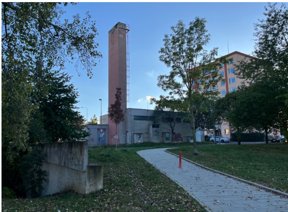
Objekt, který se může stát součástí uměleckého díla
