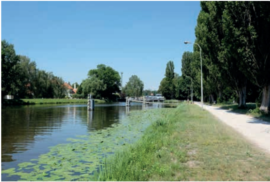
4 okolí plavební komory
