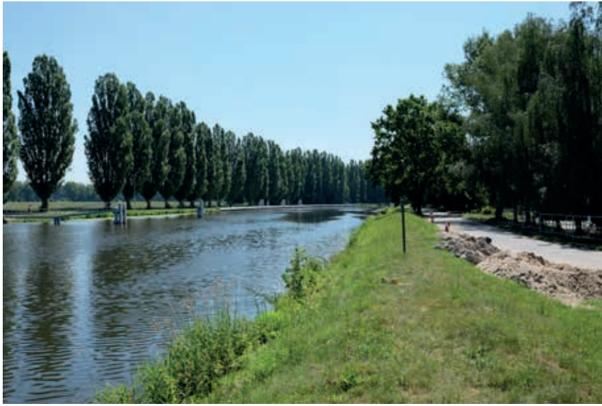
8 plavební kanál z říčního ostrova
