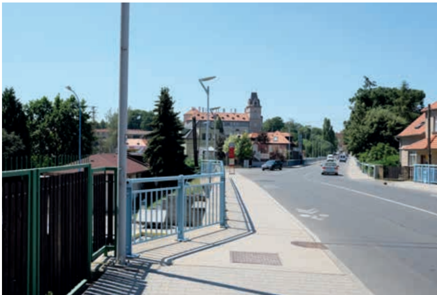
6 silniční most přes plavební kanál
