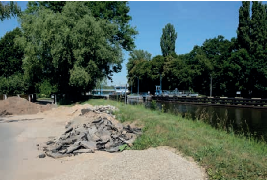
3 okolí plavební komory
